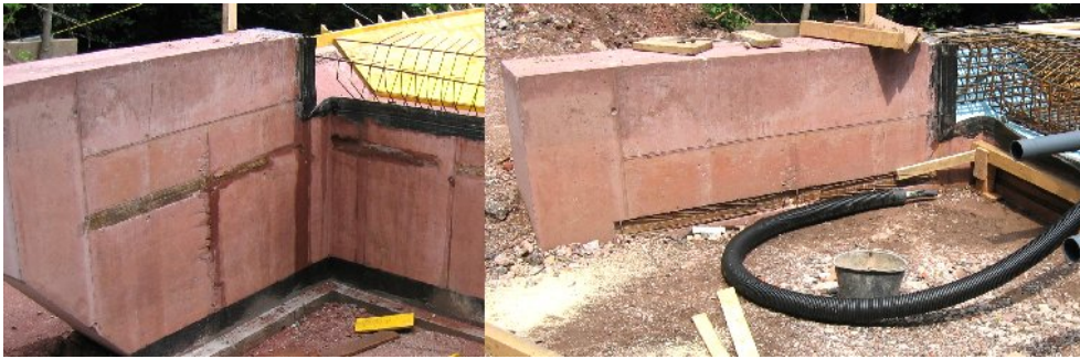
Abbildung 2: Die in die Widerlagerwände eingebaute Anschlussbewehrung markiert den Ort der Rauber-Schulter zwischen Hinterfüllung und Straßentragschicht. Rechts: vor dem Einbau der Sauberkeitsschicht.
