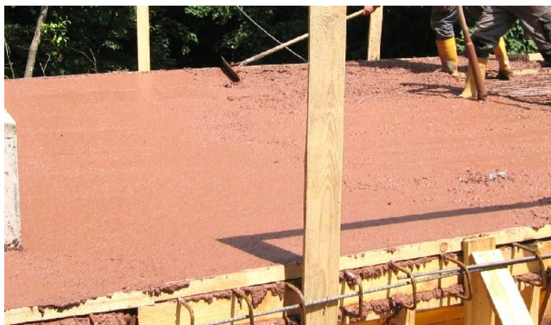
Abbildung 4: Der zum Teil betonierte und abgezogene Überbau. Wie bereits für die Widerlager wird auch hier ein rot pigmentierter Beton (C35/45) verwendet, der optisch dem natürlich anstehenden Buntsandstein sehr nahe kommt, ohne dass dabei die markante Sichtbetoncharakteristik verloren geht.
