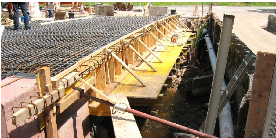
Abbildung 3: Der fertig bewehrte Überbau. Die maximale Überhöhung der Schalung beträgt 80 mm (rechts: die alte Bühlhofbrücke).
