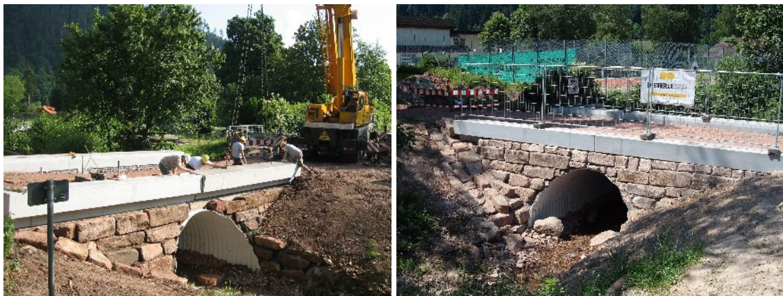
Abbildung 4: Instandsetzung einer Bachüberbrückung (Schiltach 2009) mit Fertigteil-Brückenkappen System „DiZwo“
