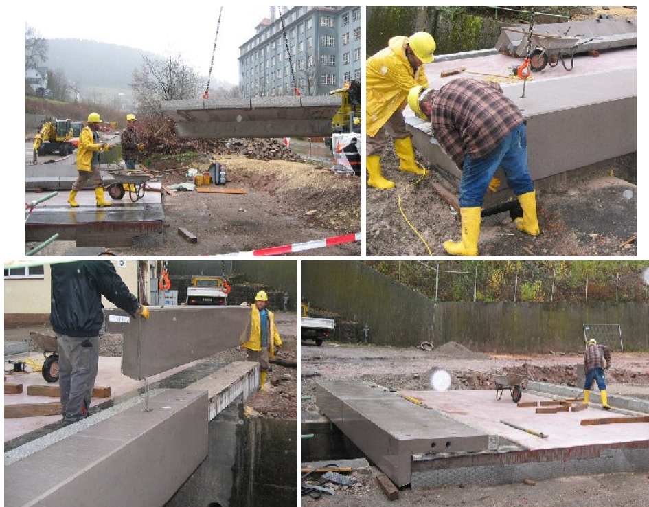
Abbildung 2: Versetzen der Fertigteile: Auch bei Minusgraden wird nach kürzester Montage-dauer bei optimaler Sichtbetonqualität der erforderliche Frost-Tausalz-Widerstand gewähr-leistet
