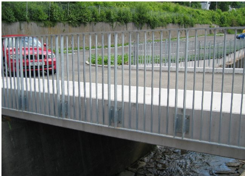
Abbildung 3: Der fertige Neubau einer Straßenbrücke (Schramberg, November 2008) mit Fertigteil-Brückenkappen System „DiZwo“
