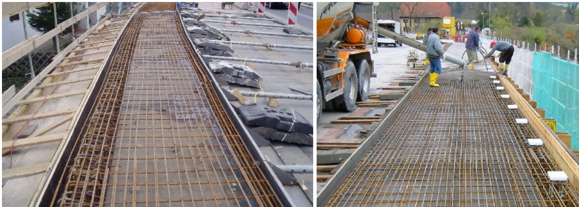
Abbildung 1: Herstellung von Ortbeton-Brückenkappen: aufwändige Schalungs- und Rüstarbeiten sowie hoher Schwindbewehrungsgrad der langgezogenen Bauteile. Nur selten sind die Betonier- und Wetterbedingungen so günstig, wie auf dem Bild rechts.
