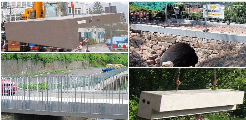
Abbildung 4: In optimaler Sichtbetonqualität hergestellte Fertigteil-Brückenkappen System „DiZwo“. Die hervorragende Nachbehandlung und Aushärtung im Werk garantieren die Frostsicherheit der Bauteile
