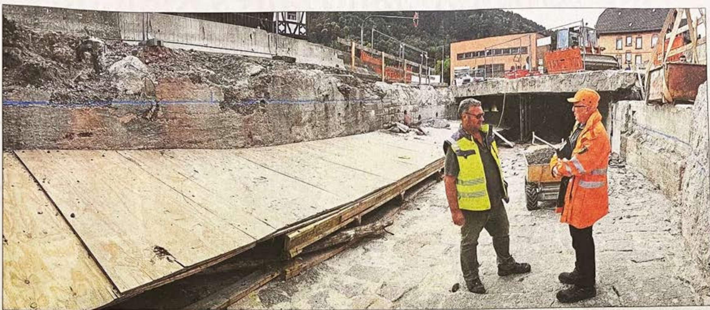
Frank Dieterle von der Baufirma Dizwo (links) und Gerhard Holzbaur vom Baureferat Donaueschingen des Regierungspräsidiums besprechen am Tunneleingang der Göttelbachverdolung das weitere Vorgehen. Entlang der blauen Striche kommt ab dem heutigen Freitag die Säge zum Einsatz. Fotos: Riesterer
